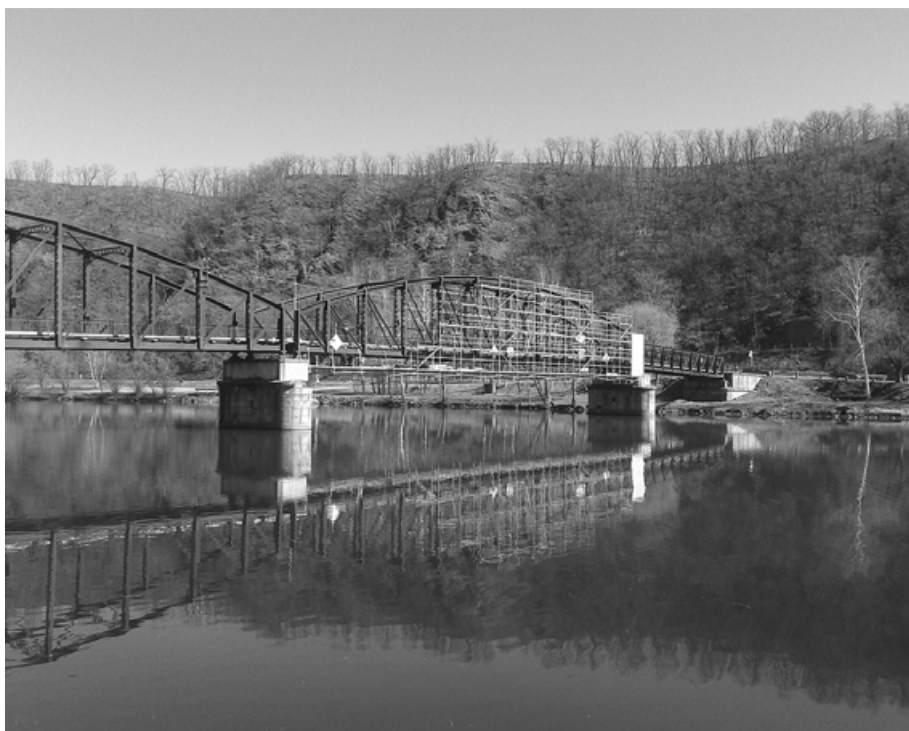
15. 3. 2017 začala plánovaná údržba Starého davelského mostu a v jejím průběhu může dojít k omezení užívání lávky pro pěší.
