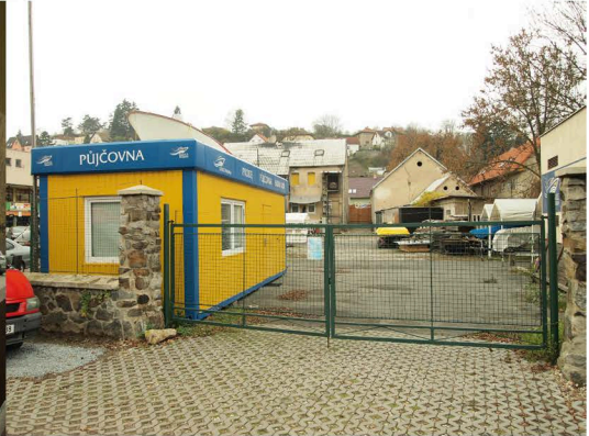
fotografie současného stavu - marina
