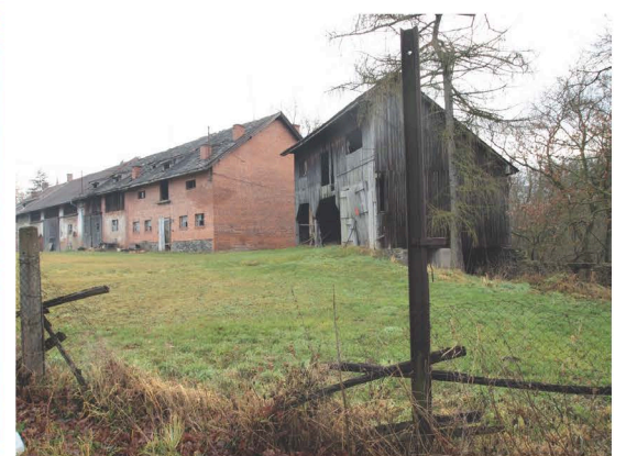
místo přemístění sběrného dvoru
