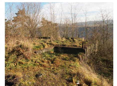
základy kulis kostela využité pro stavbu rozhledny
