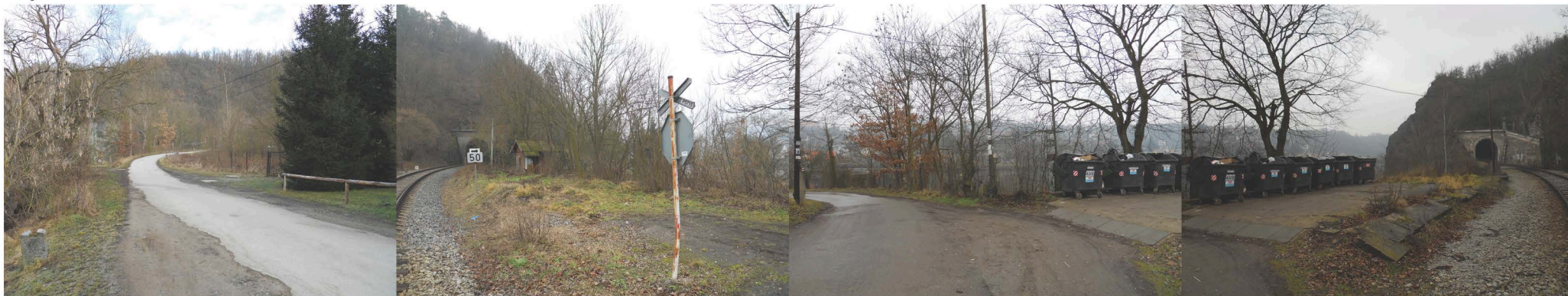
fotografie současného stavu
