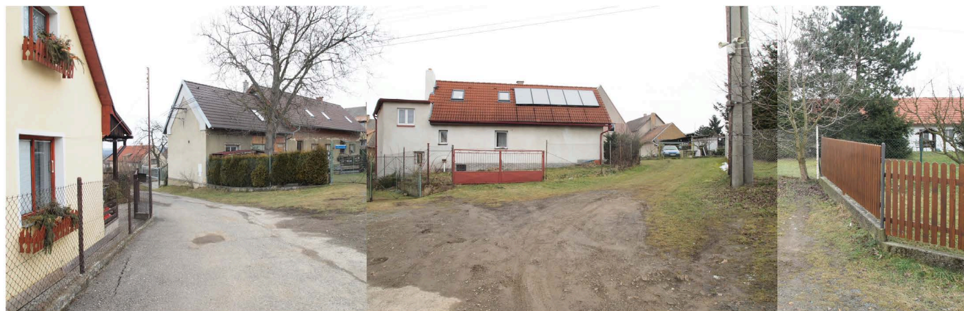
fotografie současného stavu
