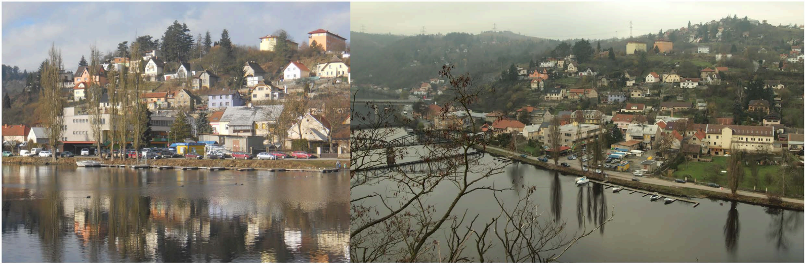
fotografie současného stavu - pohled na celek z druhé strany řeky
