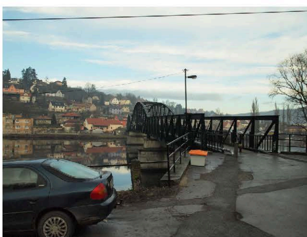
současný stav mostu
